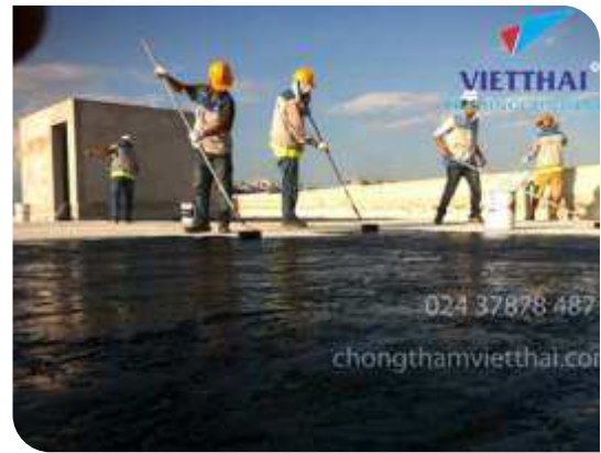
Thi công lăn lớp lót
