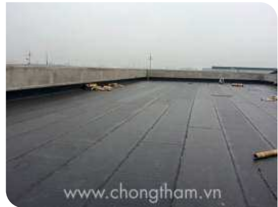
Bề mặt hoàn thiện
