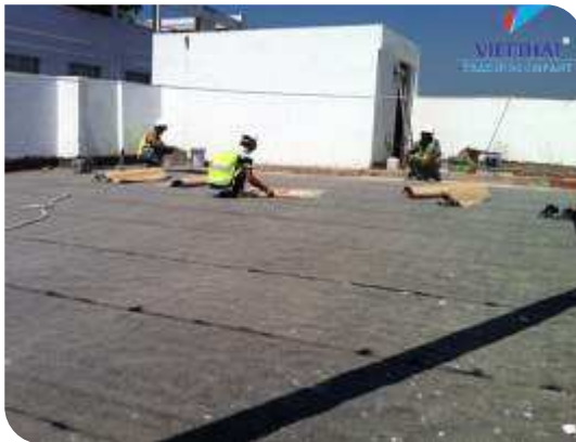
Thi công màng tự dính
