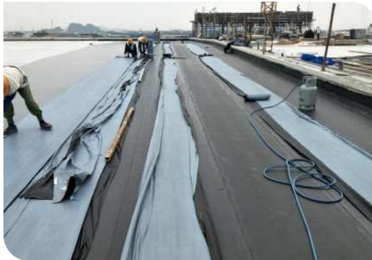
Thi công màng khô nóng
