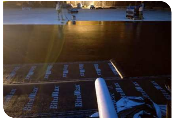
Thi công lăn lớp lót
