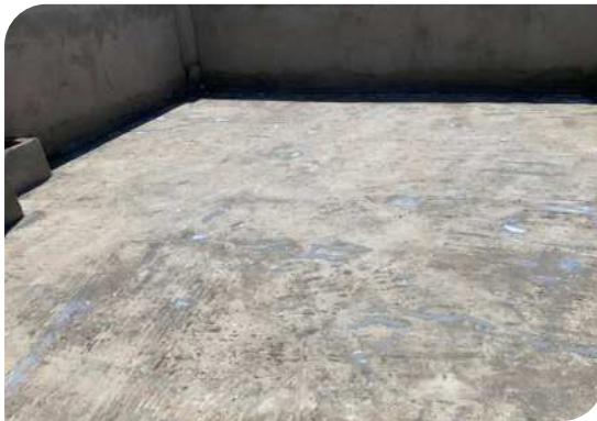
Chuẩn bị bề mặt
