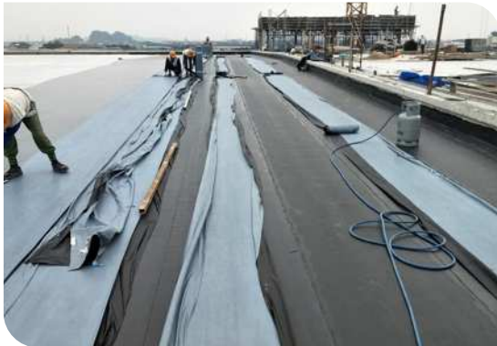
Thi công màng khò nóng
