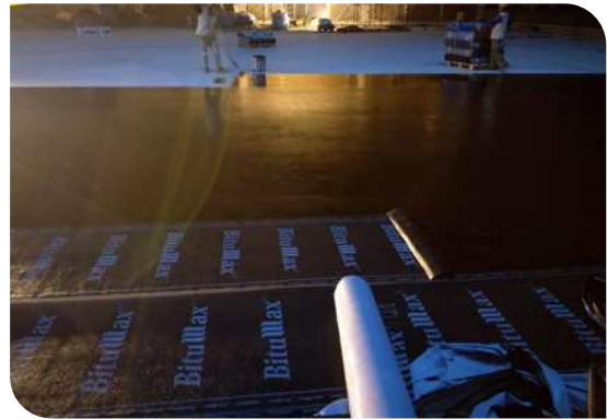
Thi công lăn lớp lót
