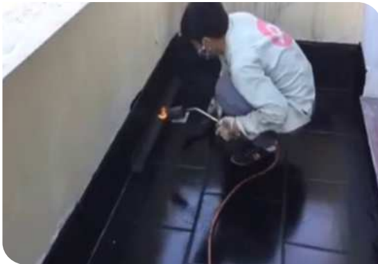
Xử lý góc chân tường
