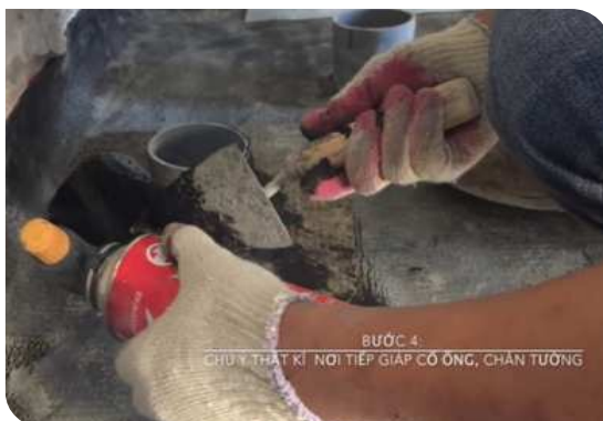
Xử lý cổ ống thoát nước
