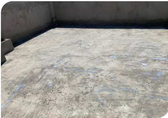
Chuẩn bị bề mặt
