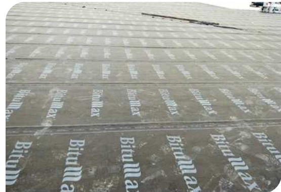
Bề mặt hoàn thiện
