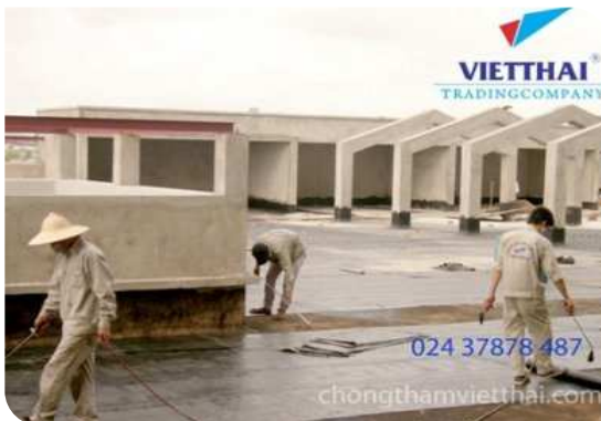
Thi công màng khô nóng
