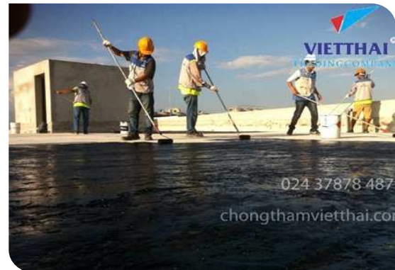
Thi công lăn lớp lót
