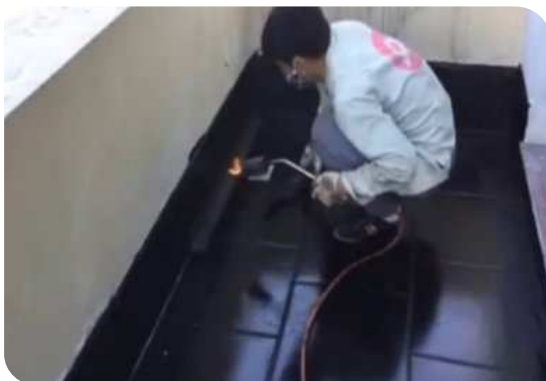
Xử lý góc chân tường
