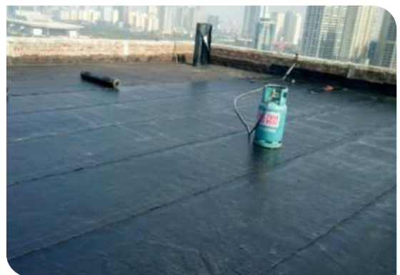
Bề mặt hoàn thiện
