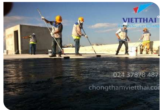
Thi công lăn lớp lót
