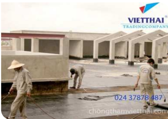
Thi công màng khô nóng
