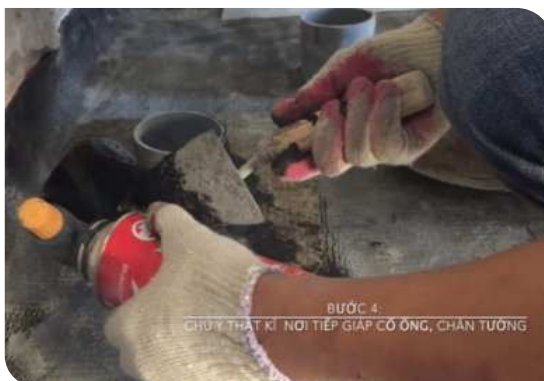
Xử lý cổ ống thoát nước
