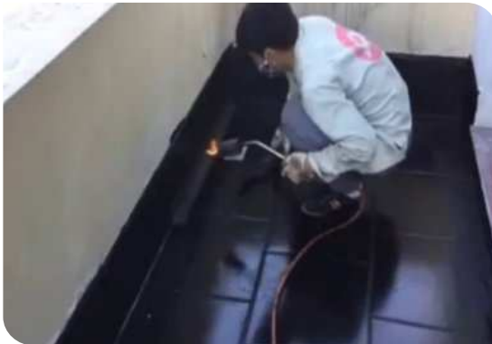
Xử lý góc chân tường
