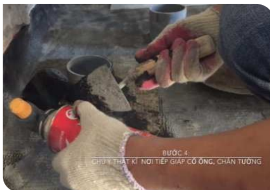
Xử lý cổ ống thoát nước
