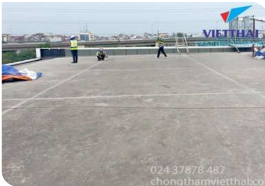
Chuẩn bị bề mặt
