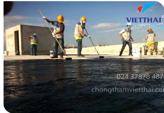
Thi công lăn lớp lót
