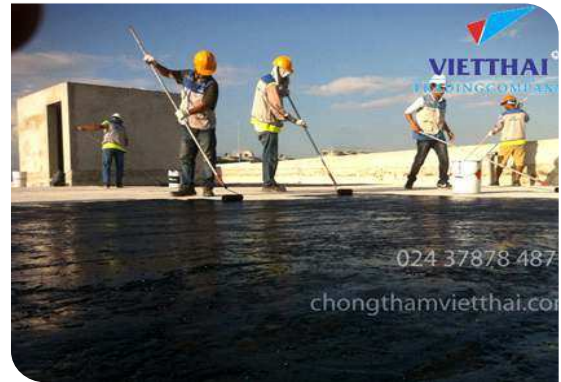
Thi công lăn lớp lót
