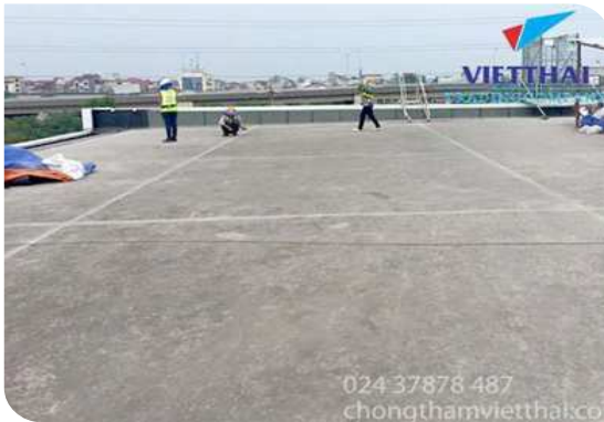
Chuẩn bị bề mặt
