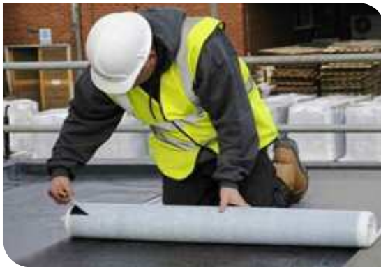
Thi công màng tự dính
