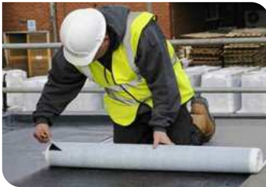
Thi công màng tự dính
