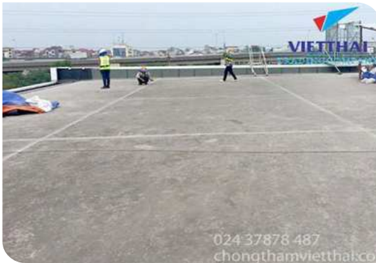
Chuẩn bị bề mặt
