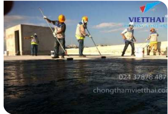
Thi công lăn lớp lót
