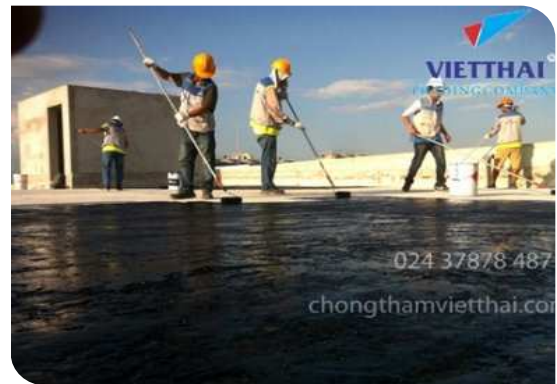
Thi công lăn lớp lót
