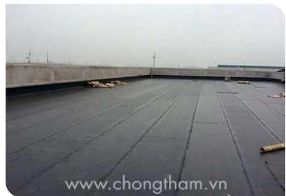
Bề mặt hoàn thiện
