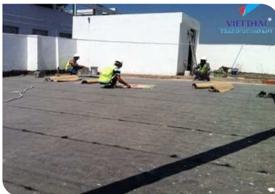
Thi công màng tự dính
