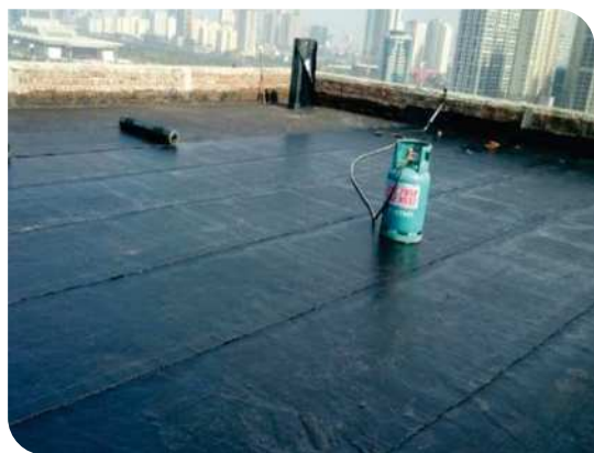
Bề mặt hoàn thiện
