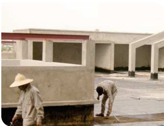
Thi công màng khô nóng
