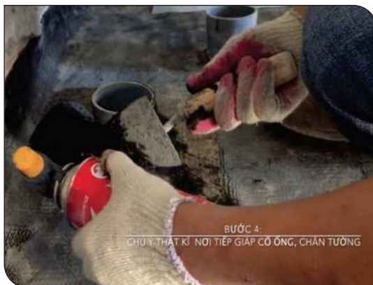
Xử lý cổ ống thoát nước
