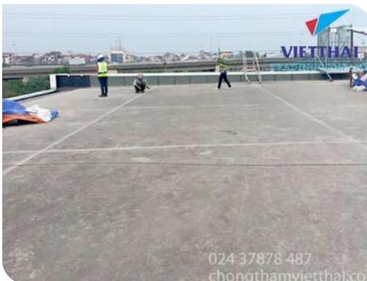
Chuẩn bị bề mặt
