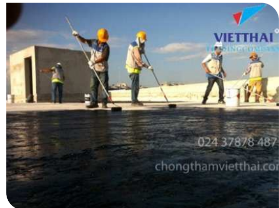
Thi công lăn lớp lót
