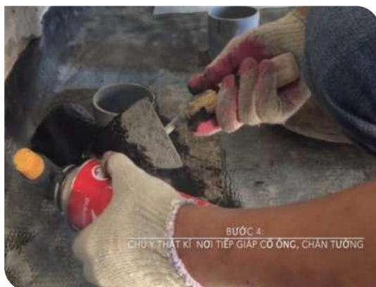
Xử lý cổ ống thoát nước
