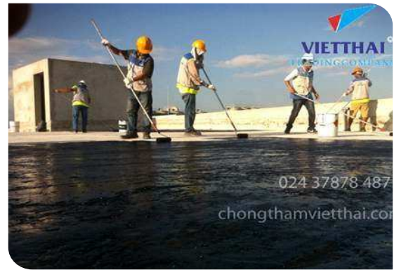
Thi công lăn lớp lót
