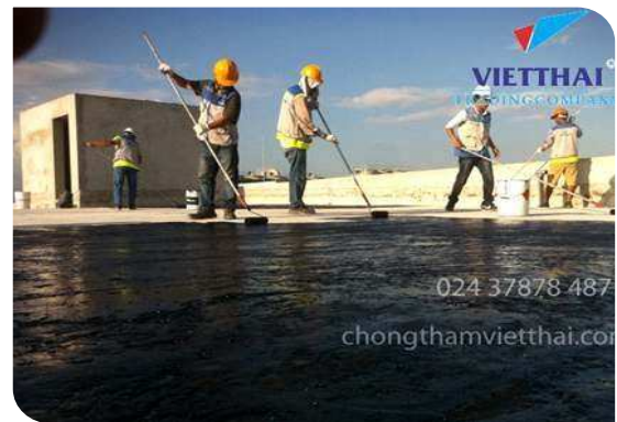
Thi công lăn lớp lót
