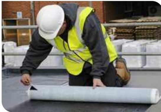
Thi công màng tự dính
