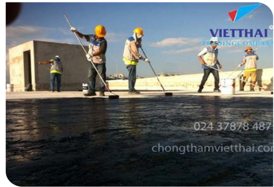
Thi công lăn lớp lót
