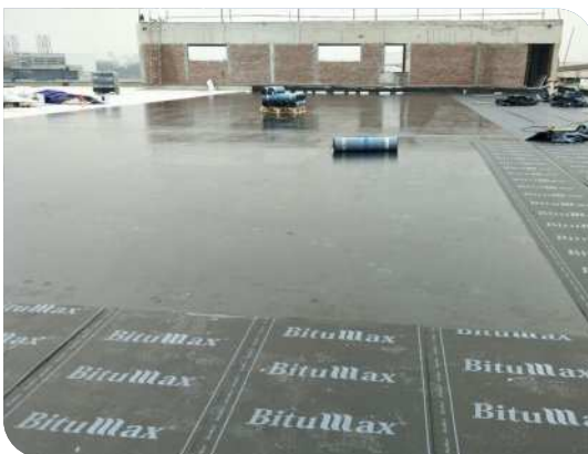
Thi công màng tự dính
