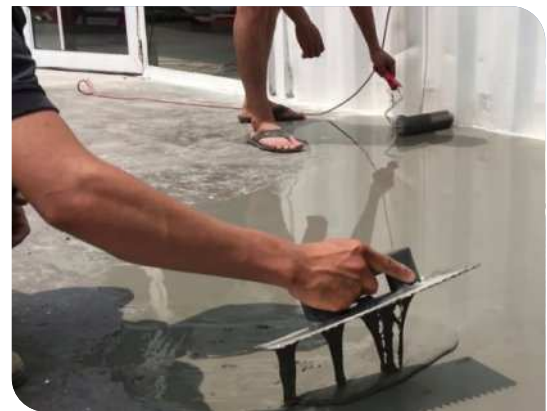
Thi công cán hồ dầu
