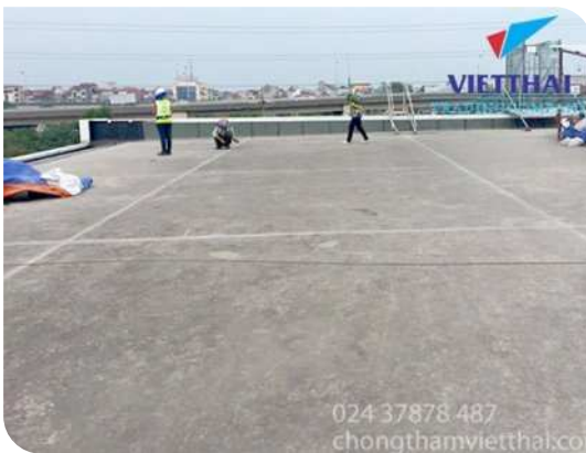
Chuẩn bị bề mặt
