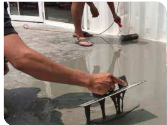
Thi công cán hồ dầu
