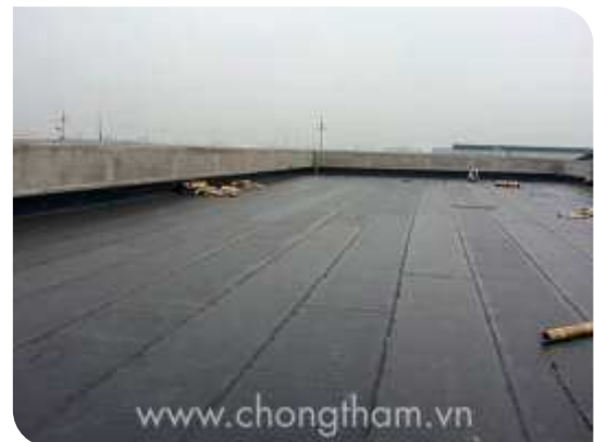
Bề mặt hoàn thiện
