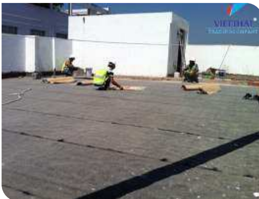
Thi công màng tự dính
