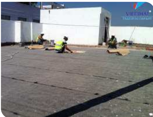
Thi công màng tự dính
