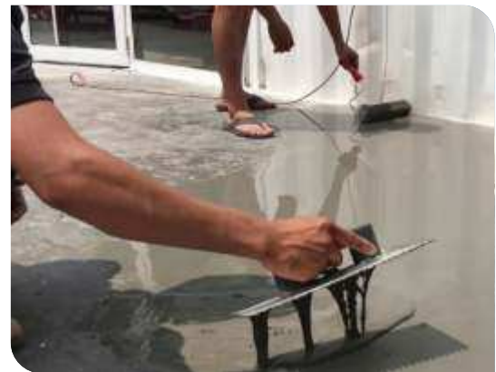
Thi công cán hồ dầu
