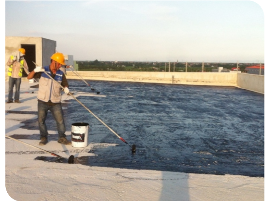
Thi công lăn lớp lót
