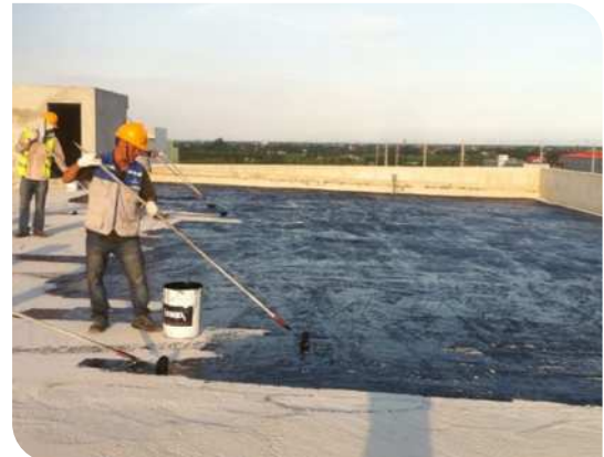
Thi công lăn lớp lót
