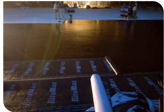
Thi công lăn lớp lót
