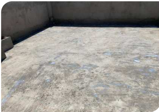
Chuẩn bị bề mặt
