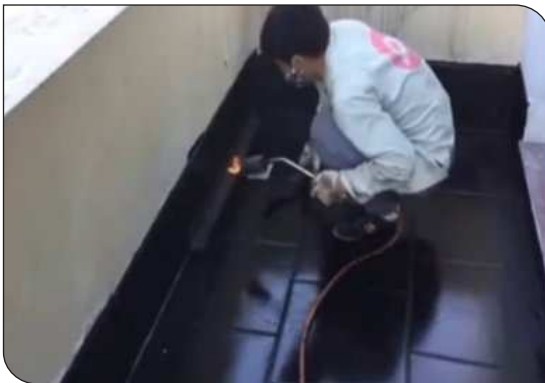
Xử lý góc chân tường
