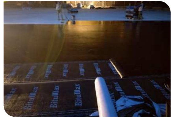
Thi công lăn lớp lót
