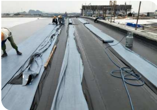
Thi công màng khô nóng
