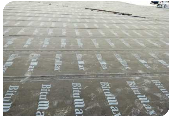
Bề mặt hoàn thiện
