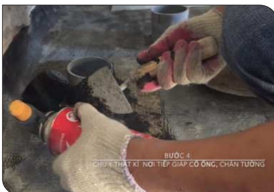
Xử lý cổ ống thoát nước
