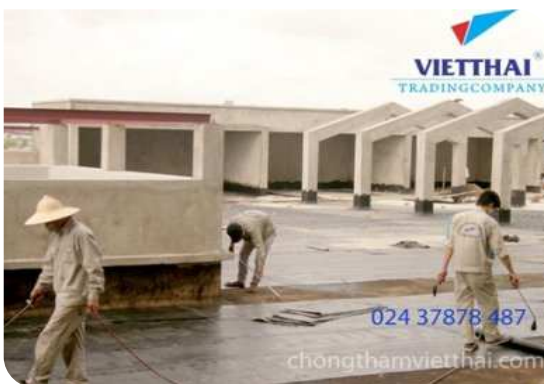
Thi công màng khô nóng
