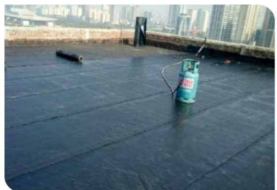
Bề mặt hoàn thiện
