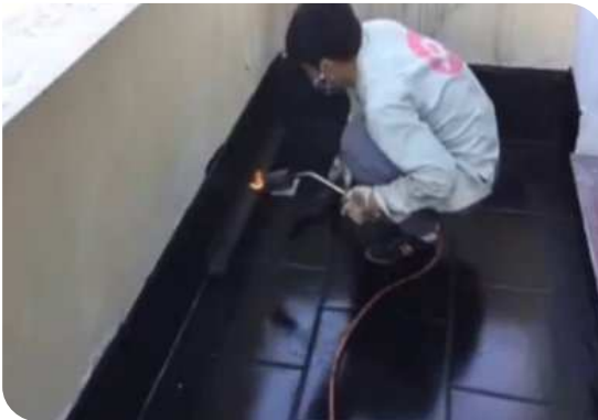
Xử lý góc chân tường
