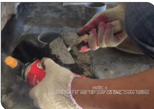
Xử lý cổ ống thoát nước
