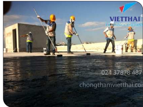
Thi công lăn lớp lót
