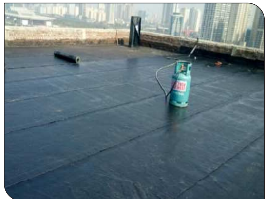
Bề mặt hoàn thiện
