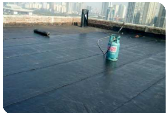
Bề mặt hoàn thiện
