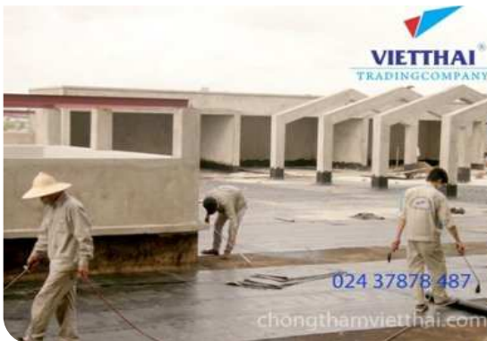
Thi công màng khô nóng
