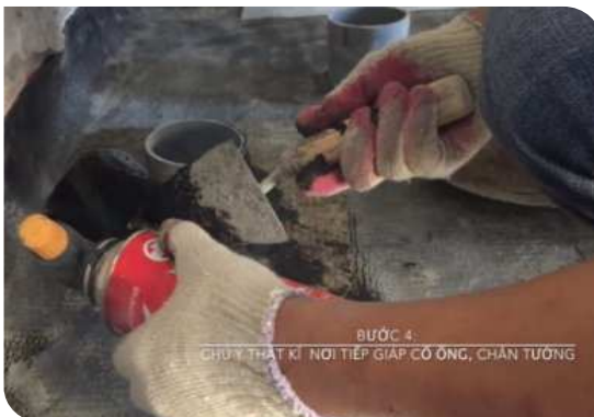
Xử lý cổ ống thoát nước
