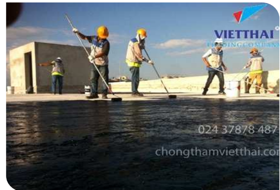
Thi công lăn lớp lót
