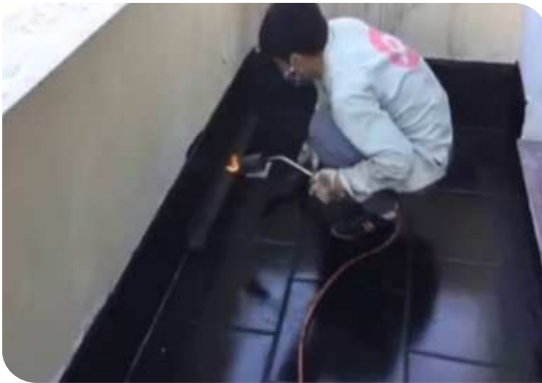
Xử lý góc chân tường
