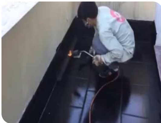
Xử lý góc chân tường
