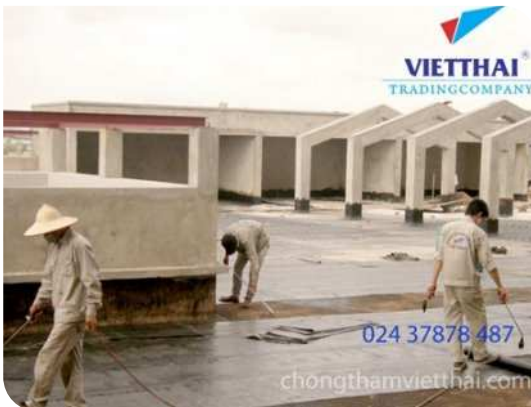
Thi công màng khô nóng
