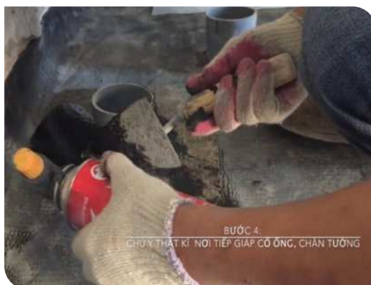
Xử lý cổ ống thoát nước
