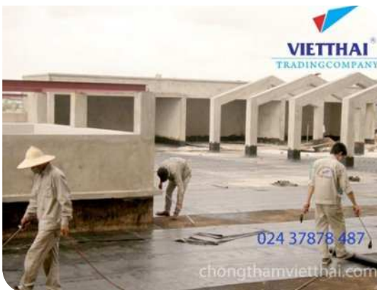
Thi công màng khô nóng
