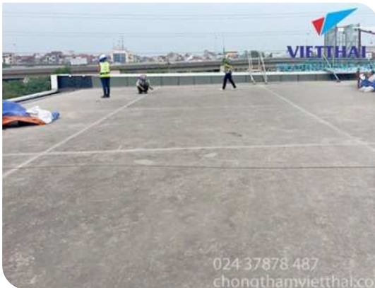
Chuẩn bị bề mặt
