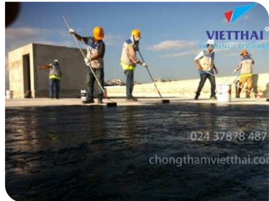
Thi công lăn lớp lót
