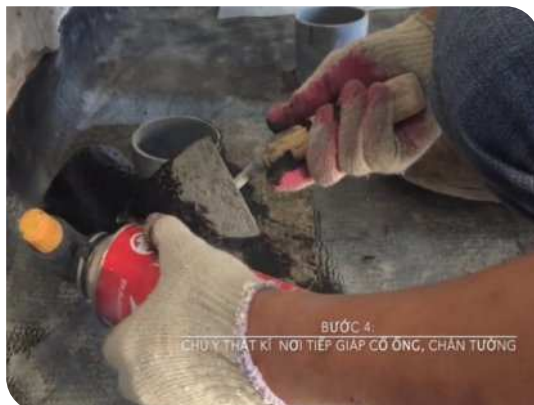
Xử lý cổ ống thoát nước
