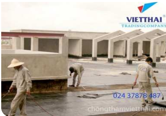
Thi công màng khô nóng
