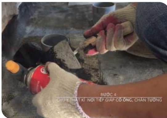
Xử lý cổ ống thoát nước
