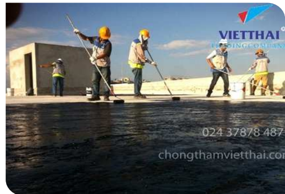
Thi công lăn lớp lót
