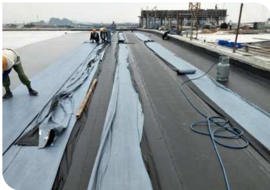
Thi công màng khò nóng
