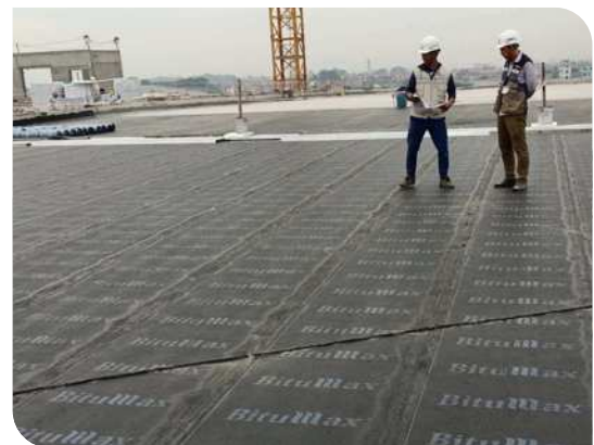
Bề mặt hoàn thiện
