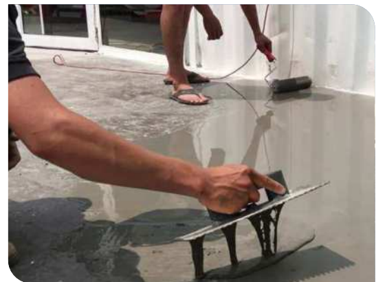
Thi công cán hồ dầu
