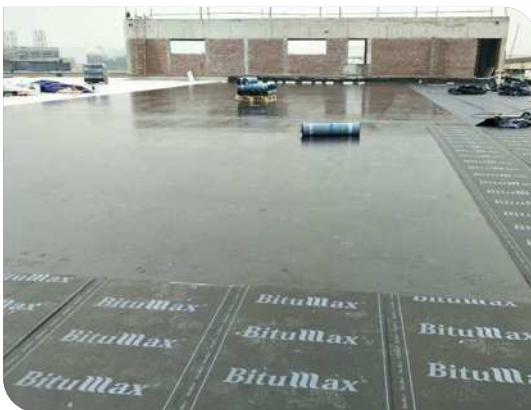
Thi công màng tự dính
