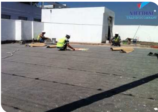
Thi công màng tự dính
