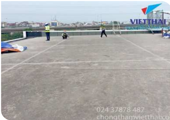
Chuẩn bị bề mặt
