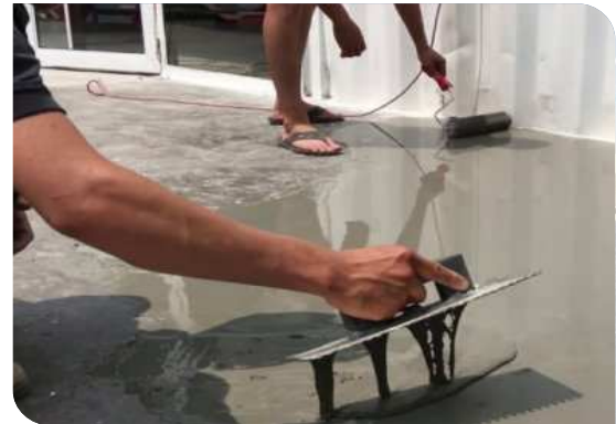
Thi công cán hồ dầu
