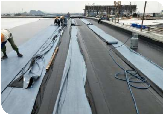
Thi công màng khò nóng
