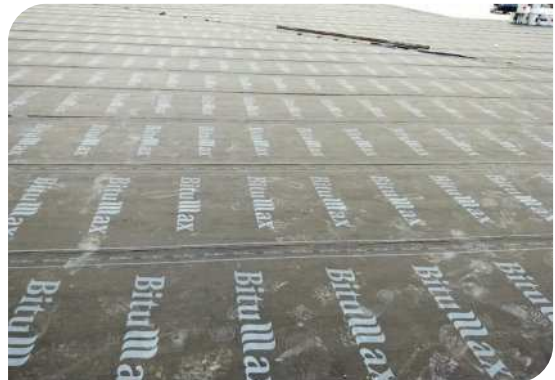
Bề mặt hoàn thiện
