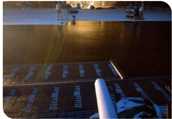
Thi công lăn lớp lót
