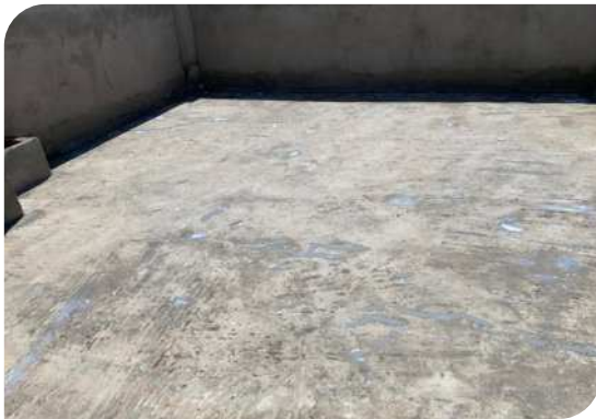
Chuẩn bị bề mặt
