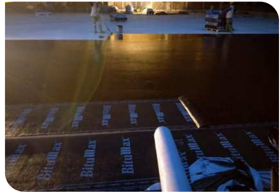
Thi công lăn lớp lót
