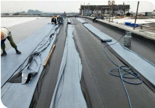
Thi công màng khò nóng
