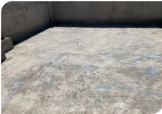
Chuẩn bị bề mặt
