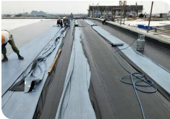
Thi công màng khô nóng
