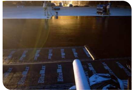
Thi công lăn lớp lót
