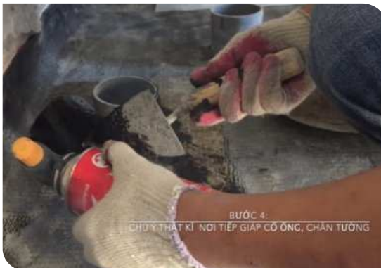
Xử lý cổ ống thoát nước
