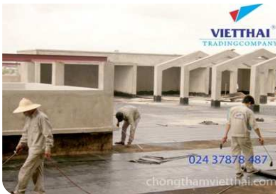
Thi công màng khò nóng
