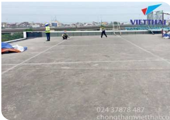
Chuẩn bị bề mặt
