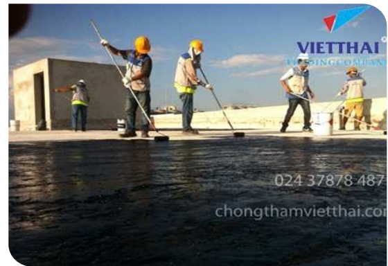
Thi công lăn lớp lót
