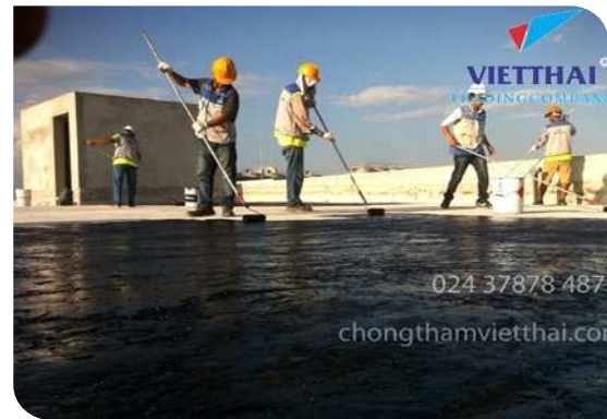
Thi công lăn lớp lót
