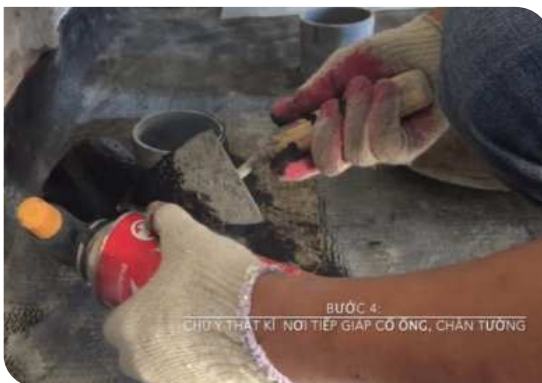
Xử lý cổ ống thoát nước
