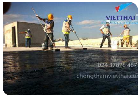
Thi công lăn lớp lót
