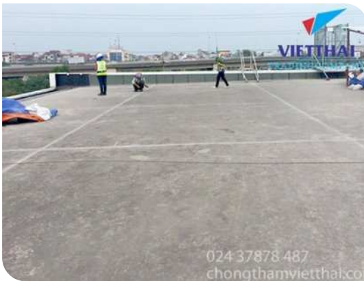
Chuẩn bị bề mặt
