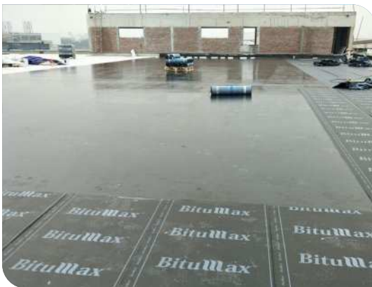
Thi công màng tự dính
