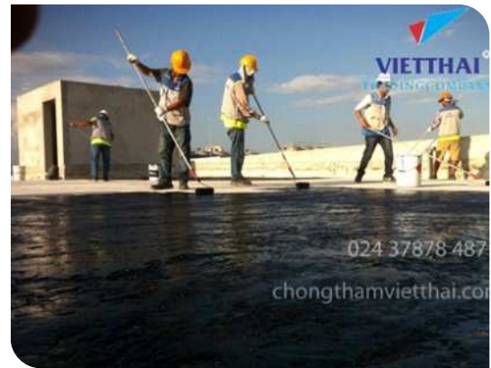
Thi công lăn lớp lót
