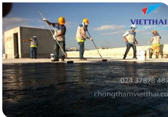
Thi công lăn lớp lót
