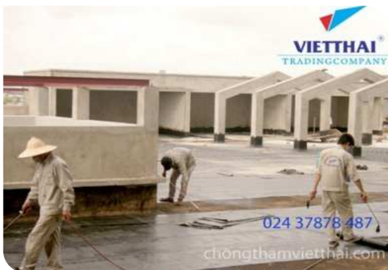
Thi công màng khò nóng
