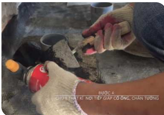
Xử lý cổ ống thoát nước
