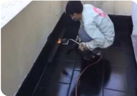
Xử lý góc chân tường
