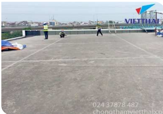
Chuẩn bị bề mặt
