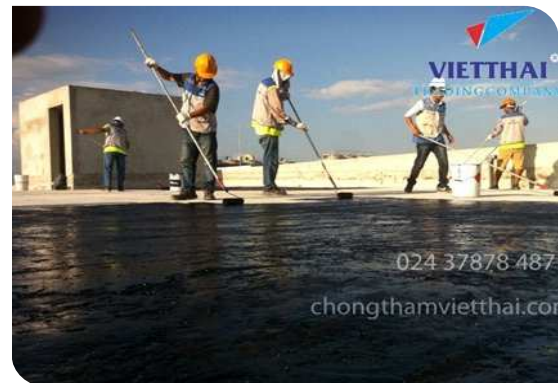
Thi công lăn lớp lót
