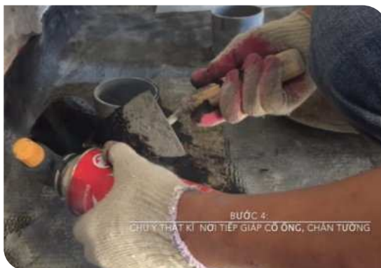
Xử lý cổ ống thoát nước
