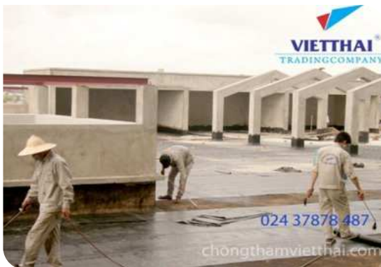
Thi công màng khô nóng
