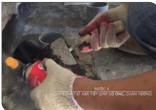
Xử lý cổ ống thoát nước
