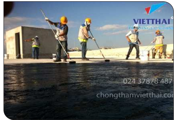
Thi công lăn lớp lót
