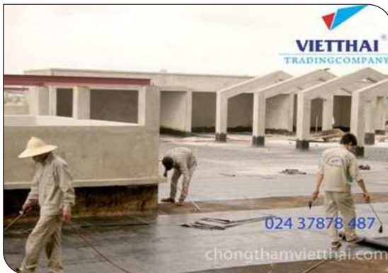
Thi công màng khô nóng
