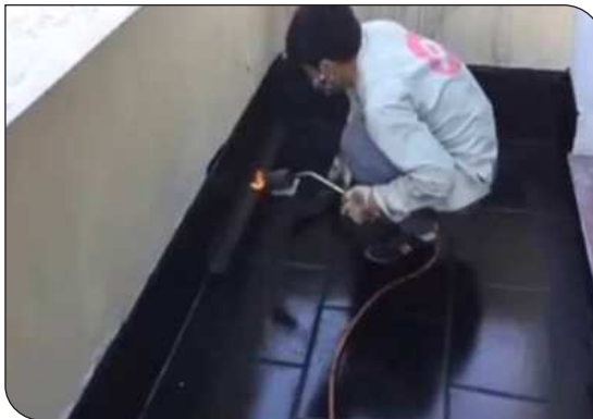
Xử lý góc chân tường
