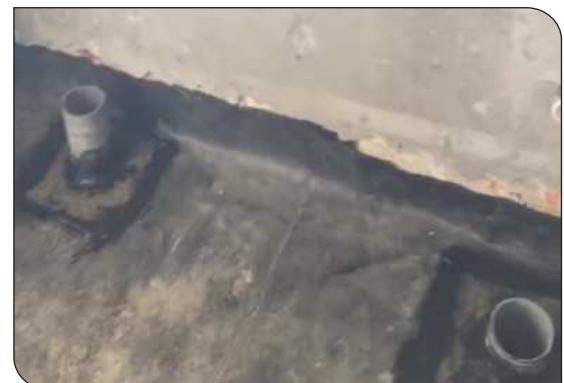
Hoàn thiện cổ ống và góc chân tường
