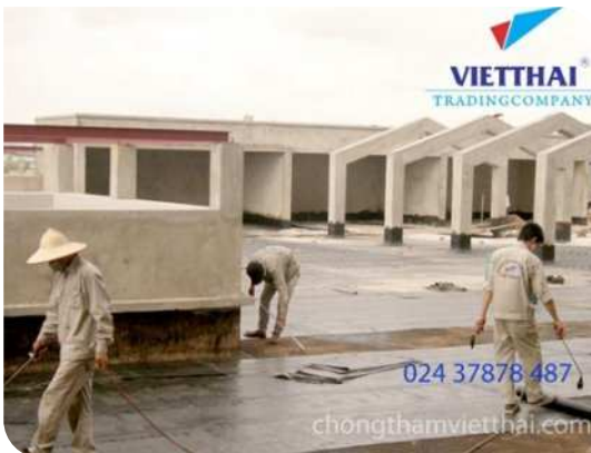
Thi công màng khô nóng
