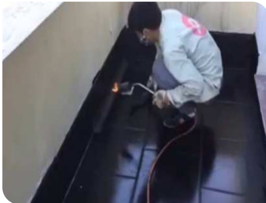
Xử lý góc chân tường
