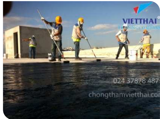
Thi công lăn lớp lót
