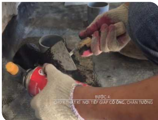
Xử lý cổ ống thoát nước
