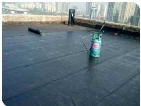
Bề mặt hoàn thiện
