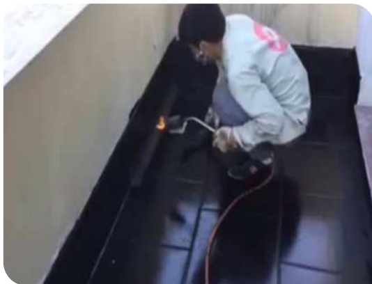
Xử lý góc chân tường
