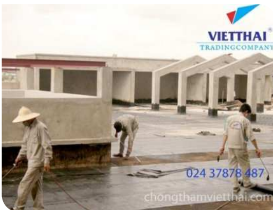
Thi công màng khô nóng
