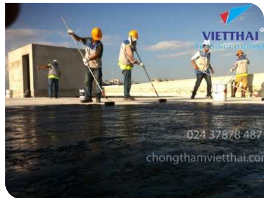
Thi công lăn lớp lót
