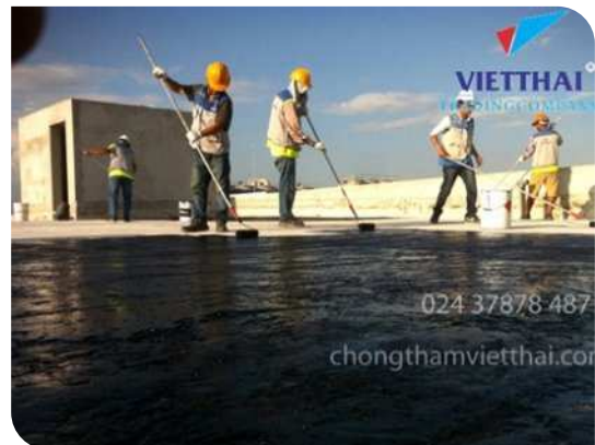
Thi công lăn lớp lót
