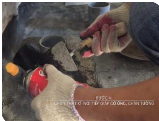
Xử lý cổ ống thoát nước
