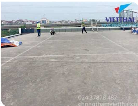
Chuẩn bị bề mặt
