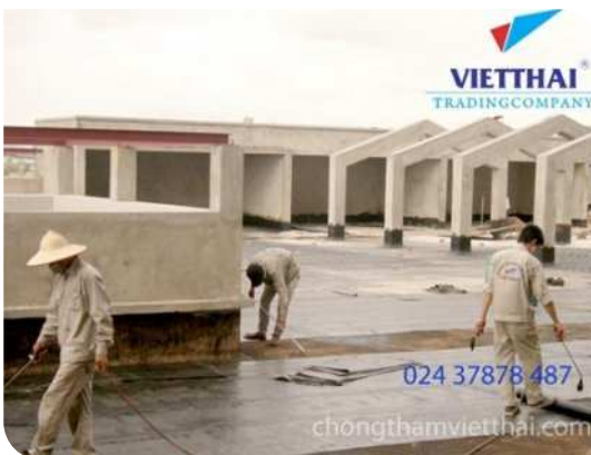
Thi công màng khô nóng
