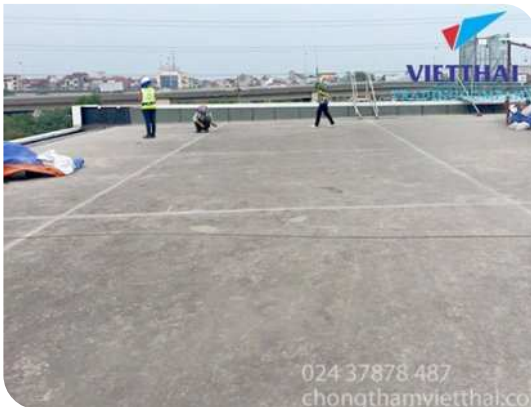
Chuẩn bị bề mặt
