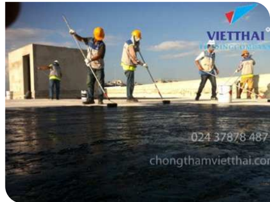
Thi công lăn lớp lót
