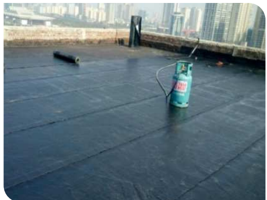
Bề mặt hoàn thiện
