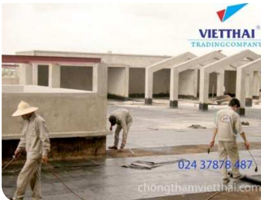
Thi công màng khô nóng
