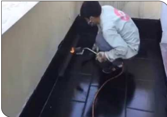
Xử lý góc chân tường
