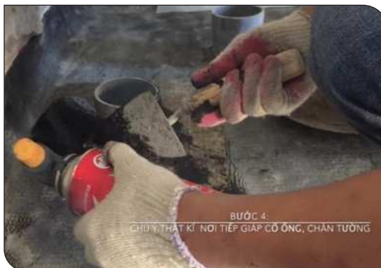
Xử lý cổ ống thoát nước
