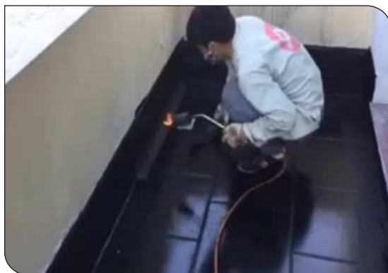
Xử lý góc chân tường
