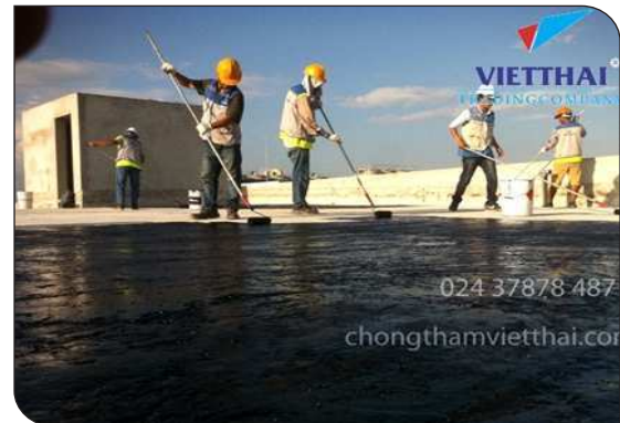
Thi công lăn lớp lót
