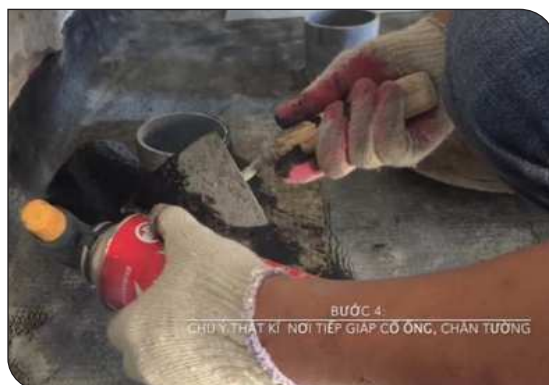
Xử lý cổ ống thoát nước
