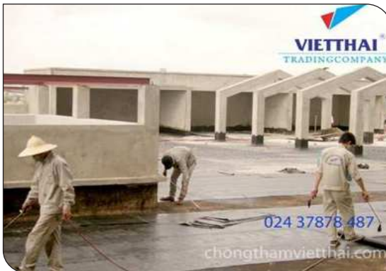
Thi công màng khò nóng
