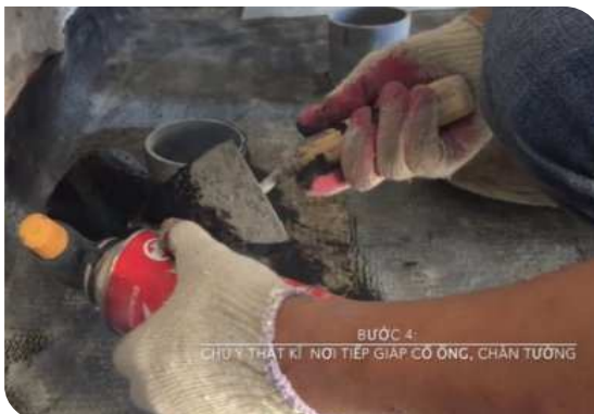
Xử lý cố ống thoát nước
