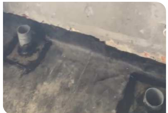
Hoàn thiện cố ống và góc chân tường
