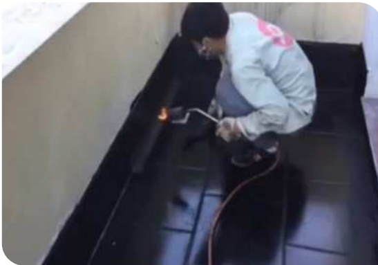
Xử lý góc chân tường
