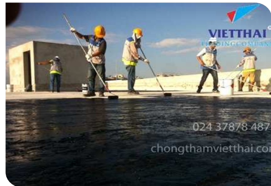
Thi công lăn lớp lót
