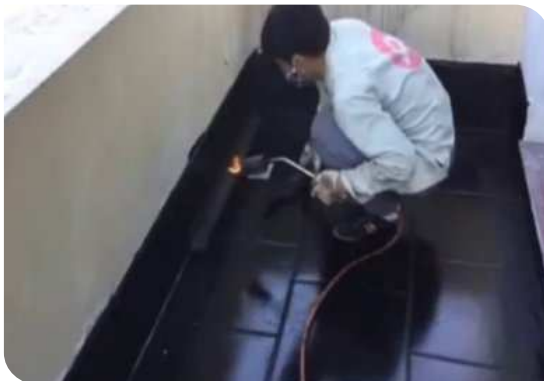
Xử lý góc chân tường
