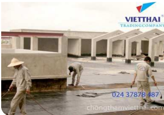
Thi công màng khò nóng
